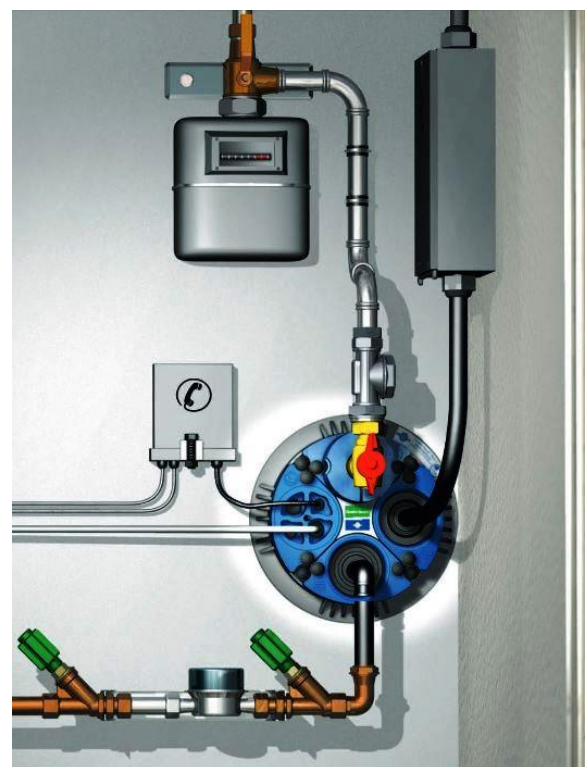
Bild 3: Draufsicht Hauseinführung Keller
