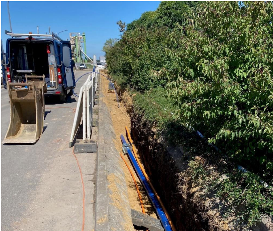
(Rohrnetzerweiterung „Am Weiher“ in Ameln im Sommer 2023)
